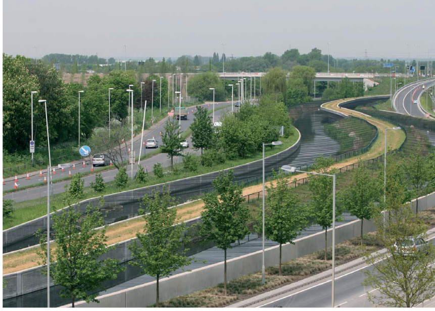
Fotoğraf 9: Şehir içersine uyarlanabilir kıyı yapısı
