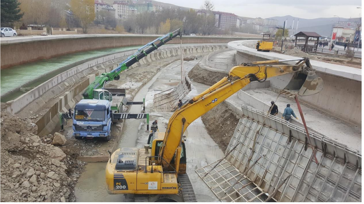
1. Etap Çoruh Islah Projesi Nehir tabanının beton kalıplarla döşenmesi
