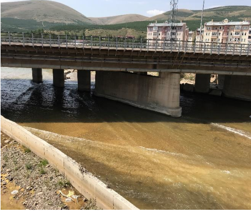
Fotoğraf 3: Erzurum köprüsü altında nehri bir kanala toplayan yanlara yapılan betonlar
