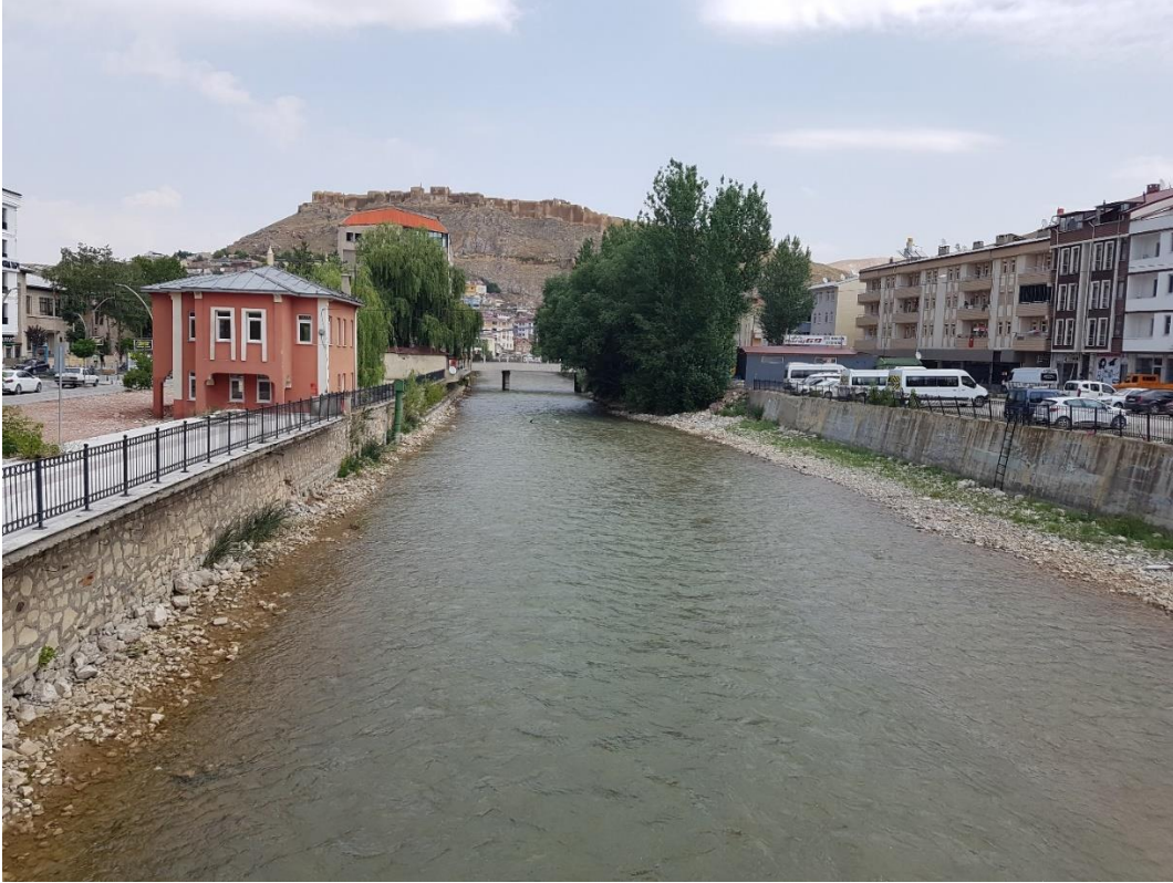
Şekil 7. Yıldırım Çayı kenarlarındaki örme taş ve beton duvarlar.
