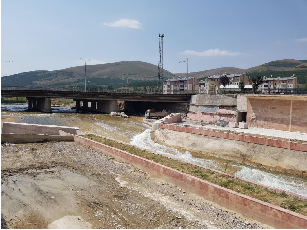
Şekil 5. Erzurum Köprüsü civarında Yıldırım Çayında yapılan ıslah ve peyzaj çalışması.
