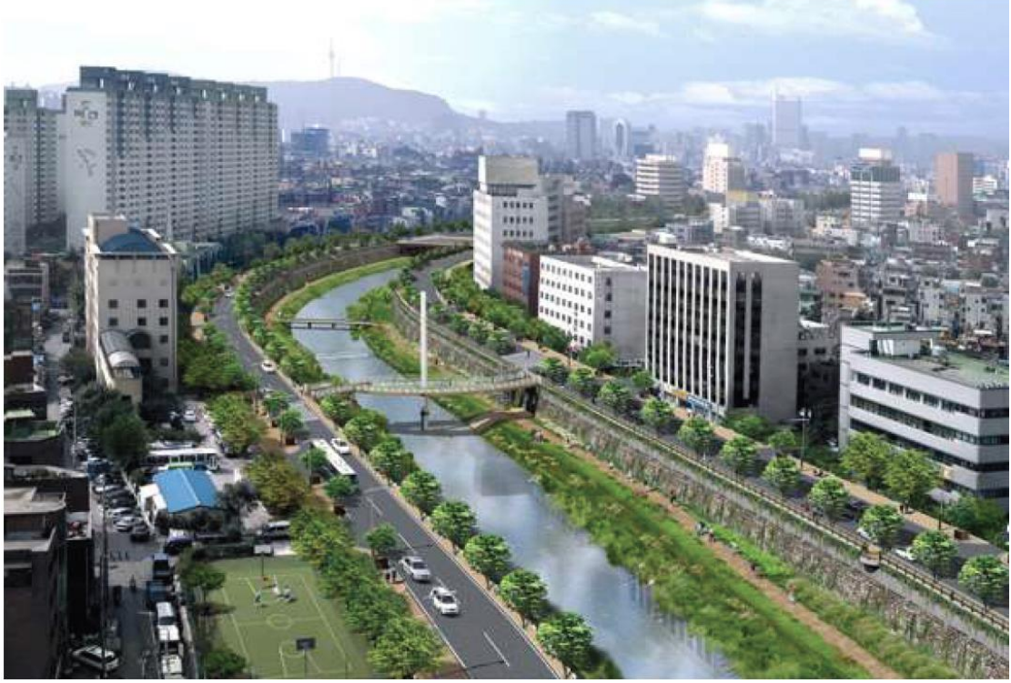
Şekil 12. Şehir içinden geçen ırmaklarda ırmağın doğal ekolojik yapısının korunduğu bir örnek
