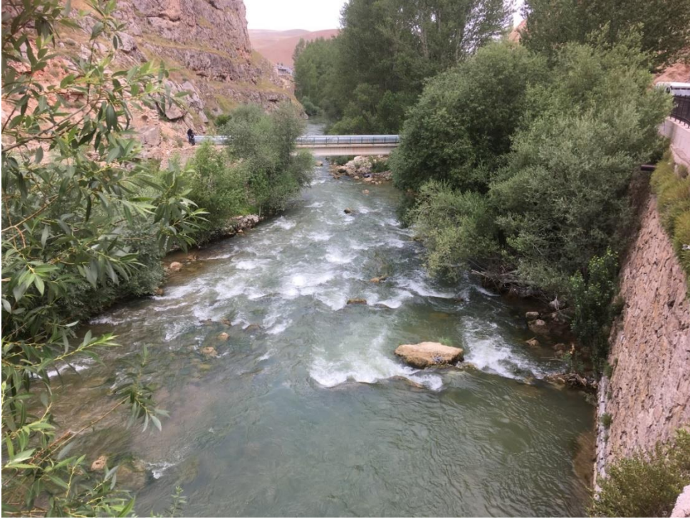
Şekil 10. 2. etap proje bitim noktası (Bent Köprüsü)
