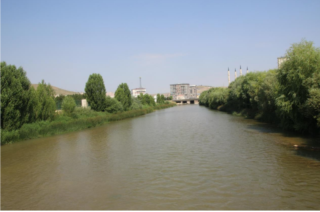
Şekil 1. Erzurum-Bayburt istikameti Çoruh nehrinin Bayburt şehir merkezine varmadan önceki yapısı
