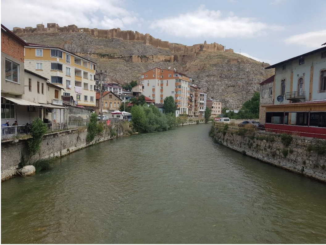
Şekil 8. Yıldırım Çayı kenarında, üzerinde bitki örtüsü gelişen örme taş duvarlar.
